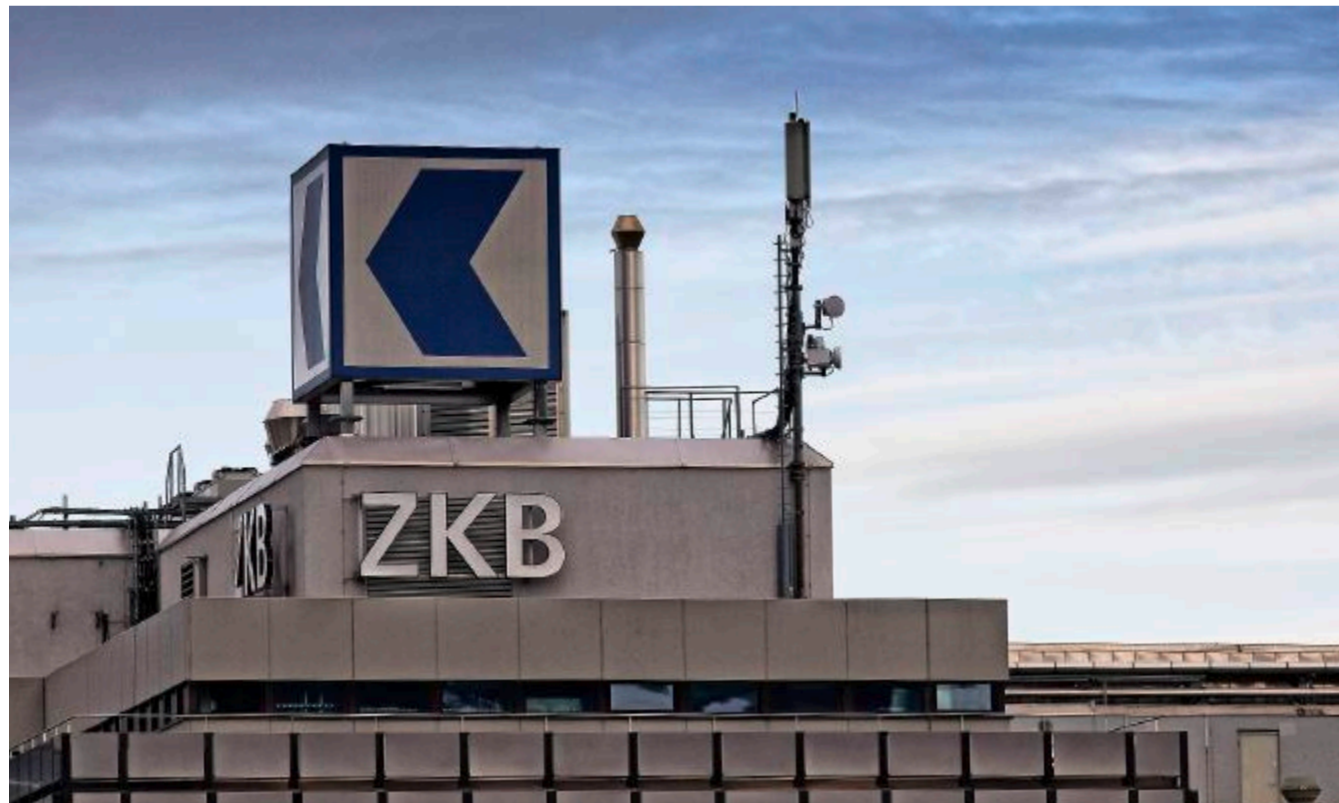
Eine kleine Grossbank: Gebäude der ZKB bei der Hardbrücke in der Stadt Zürich. Foto: Nicola Pitaro
